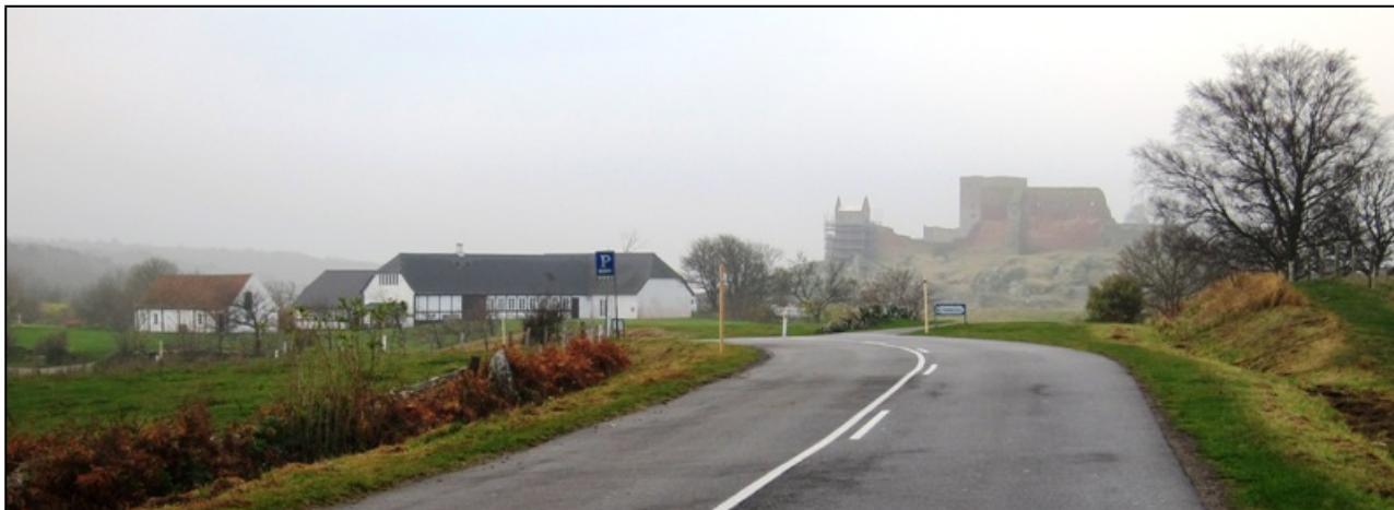
Det nuværende besøgscenter i Slotsgården ønskes nedrevet, således at sletten foran Hammershus fritlægges.
