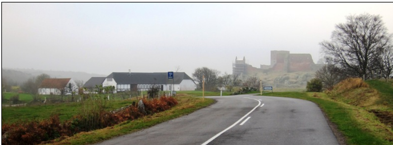
Det nuværende besøgscenter i Slotsgården ønskes nedrevet, således at sletten foran Hammershus fritlægges.
