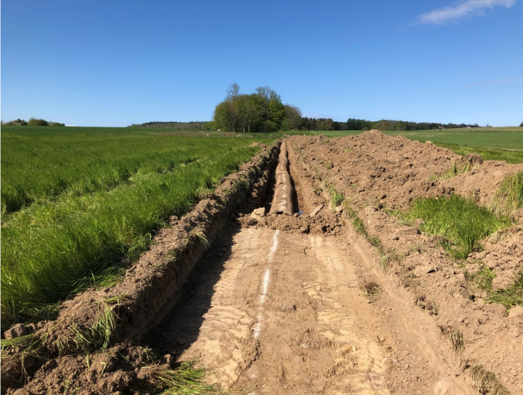
Figur 1 Første skridt i åbningen af et rørlagt vandløb, er at finde og fjerne drænrøret. Her er vi i gang med at blotlægge og fjerne betonrøret ved vandløbet Flisebækken.
