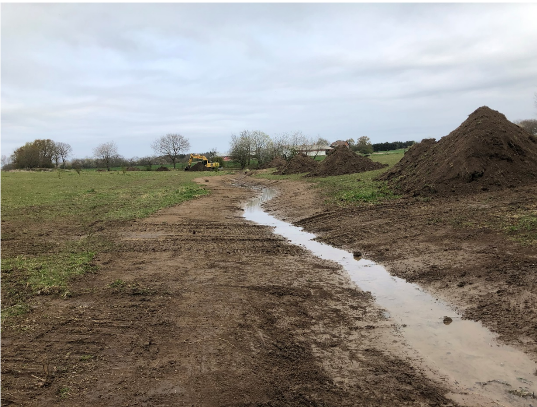
Figur 2 Åbningen af det rørlagte vandløb ved Stenløsevej. Man ser de flotte svingninger i vandløbet, samt de store bunker af overskudsjord, der senere blev kørt væk.
