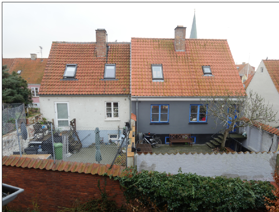
Indblik til Bødkerøgænet nr. 9 og 11 set fra eksisterende vinduer på første sal i gymnasiebygningen. Med lokalplanens vedtagelse vil der her kunne etableres altaner på bygningens facade.
