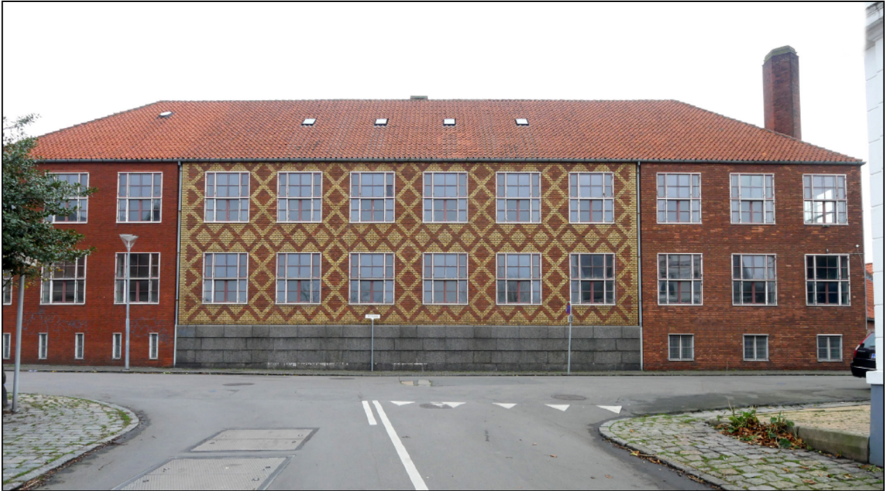
Den tredelte hovedfacade mod Storegade med det karakteristiske mønstermurværk og granitsokkel
